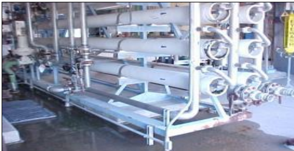
Figura 32. Sistema típico Osmosis Inversa
