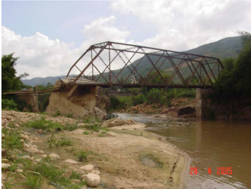
Figura 7. Fotografía Puente Nariño
