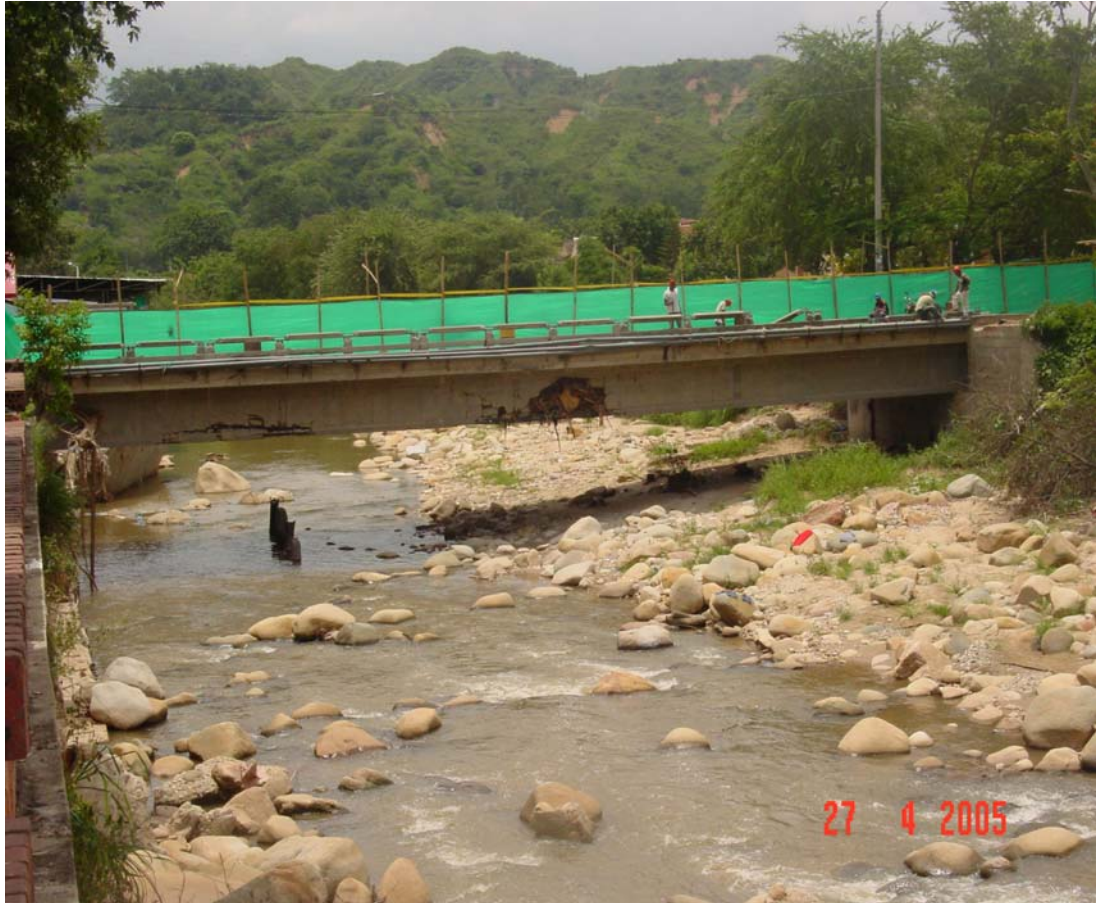
Figura 4. Fotografía Puente GEO Von Lenguerke.
