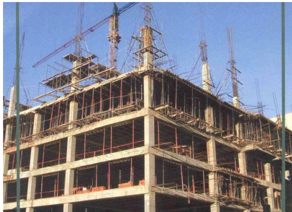
Figura 5. Construcción en Concreto Reforzado
