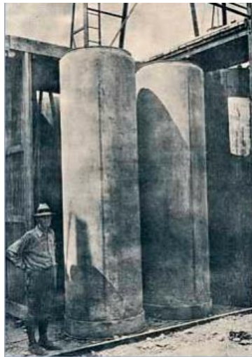
Figura 6. Tubería para el acueducto Vitelma de Bogotá
