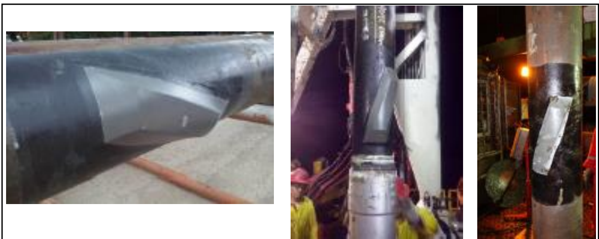
Figura 39. Centralizadores Protech CRB instalados en el Pozo C8
