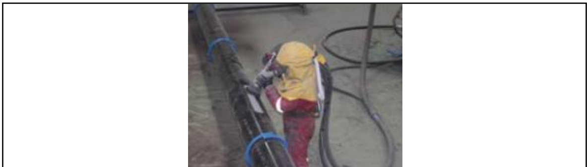
Figura 36. Pieza tratada con arena abrasiva o sandblasting
