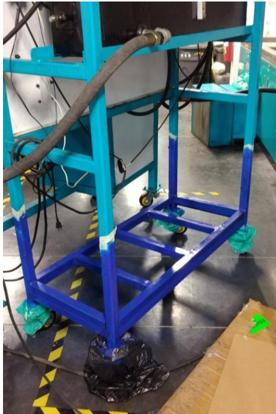
Anexo D - Construcción estructura del banco de control.
