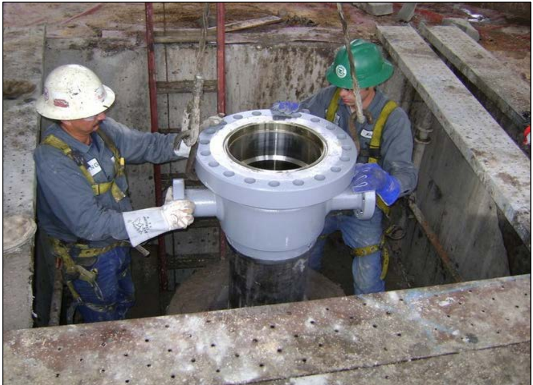
Figura 53. Casing head o sección A
