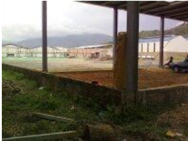
Figura 8. Visita de obra parque industrial.
