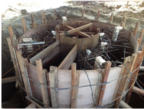
Figura 5. Armada y colocación acero chimenea de esterilización
