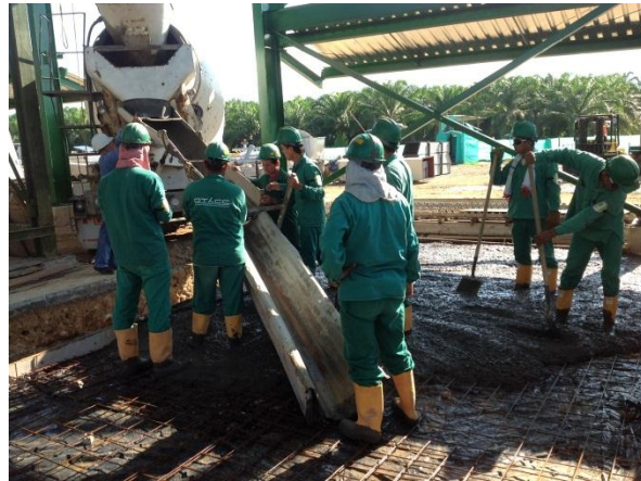
Figura 3. Fundición de placa de contra piso
