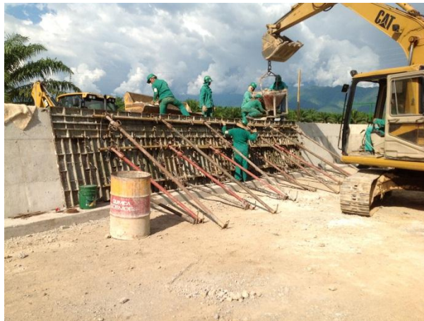
Figura 4. Fundición Muro en concreto ciclópeo
