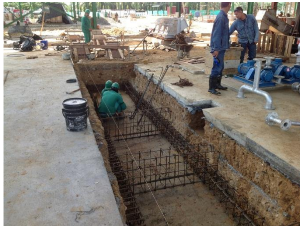
Figura 6. Armada acero bases redler de Calderas
