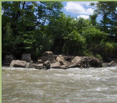
El pozo no tiene plataforma, se encontraba localizado a la margen derecha del río La Llana, la cual ha sido y esta siendo socavada por el río.
