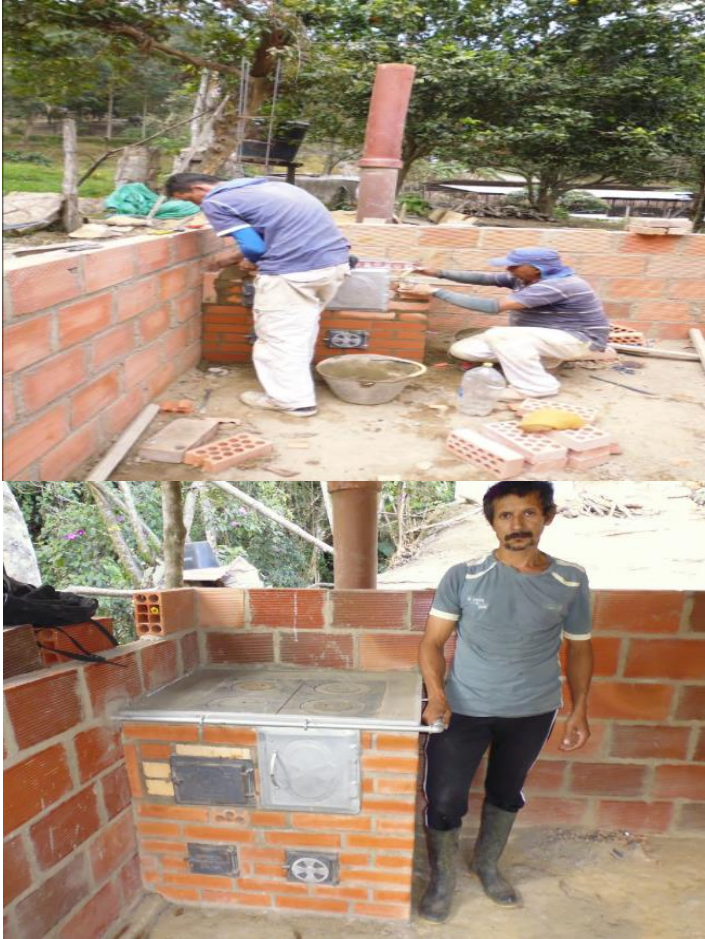
Imagen 7. Construcción de estufas.
