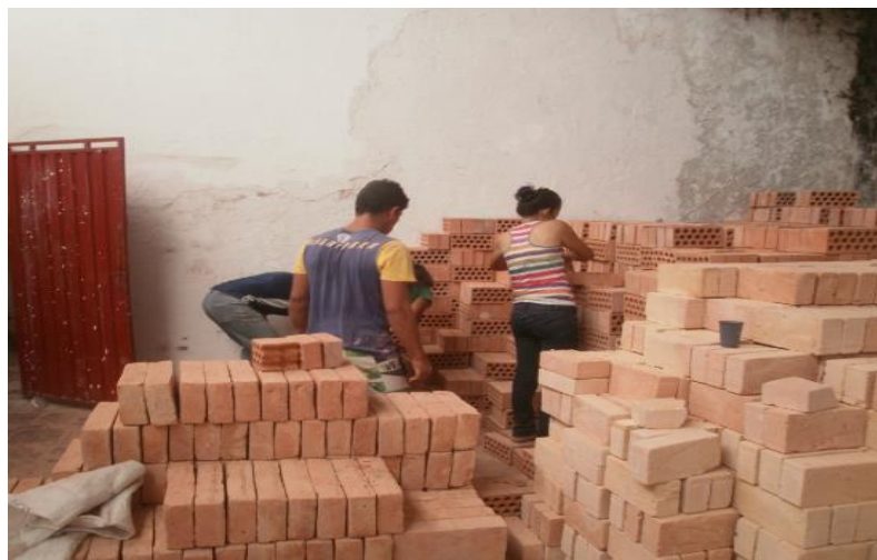
Imagen 6. Materiales de construcción.
