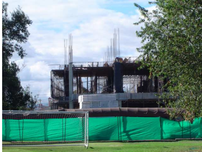
Figura 3.8. Fotografía construcción edificio de cuatro pisos Fuente: Autor
