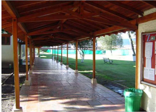
Figura 3.5. Fotografía corredor principal Fuente: Autor
