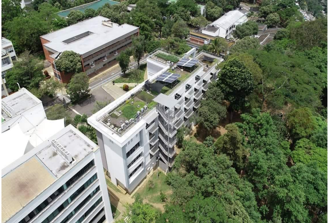
Figura 7. Vista del sistema FV instalado en el techo verde del Edificio de Ingeniería Eléctrica.
