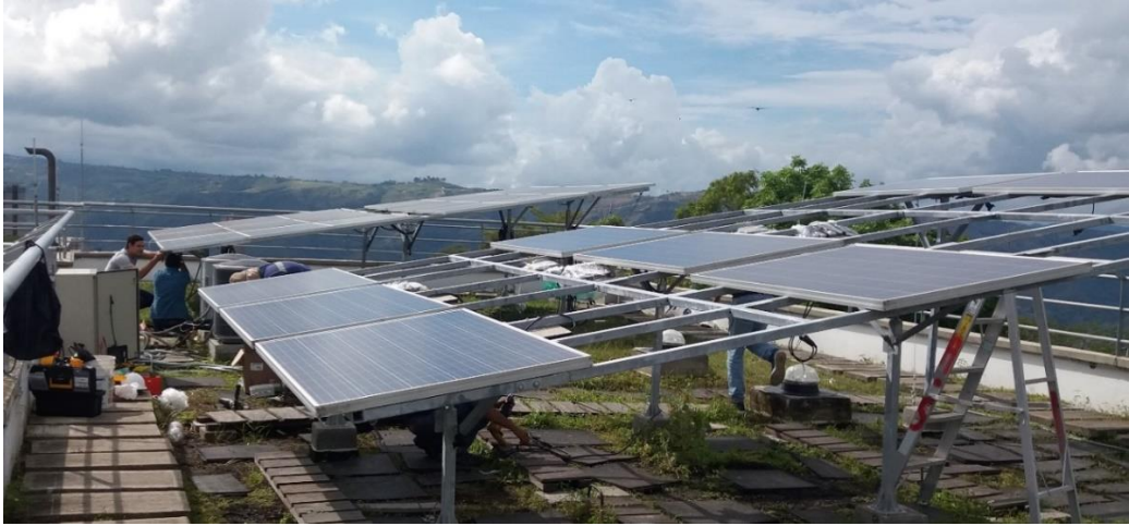
Figura 31. Día de trabajo en la instalación del sistema GRIPV #2.
