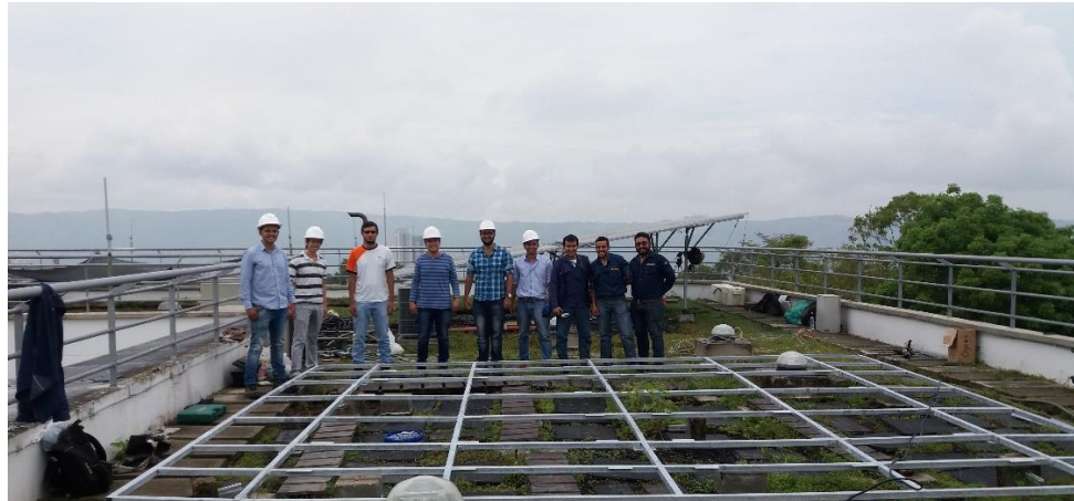
Figura 30. Día de trabajo en la instalación del sistema GRIPV #2.
