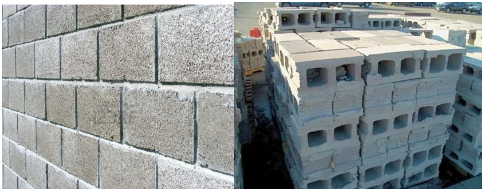
Figura 32. Pared de hormigón
