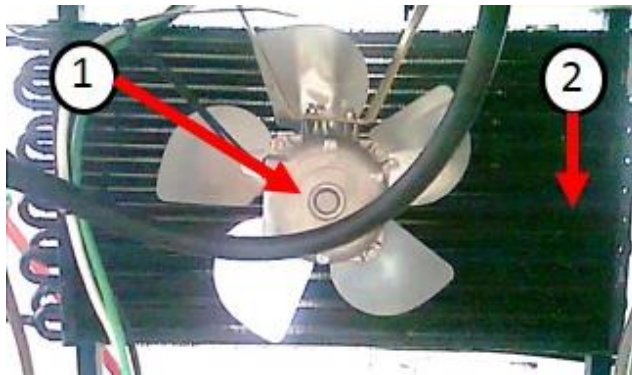
Figura 20. Conjunto radiador ventilador.
