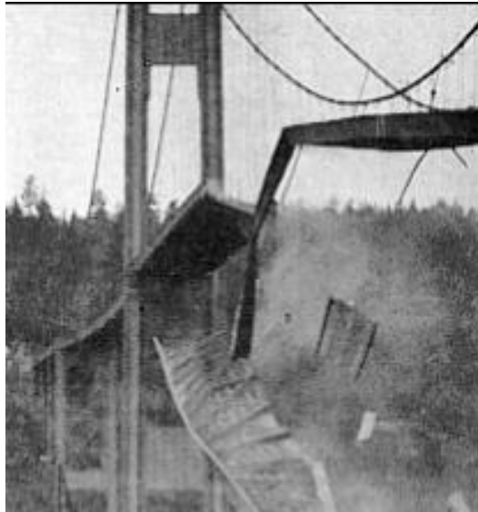
Figura 4 Colapso del tablero del puente sobre el estrecho de Tacoma.
