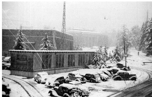
Figura 10 Primer Túnel de Viento de la Universidad de Washington
