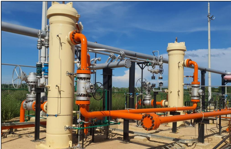
Ilustración 18. Filtros Coalescentes Fuente: Autor con datos asociados de la investigación
