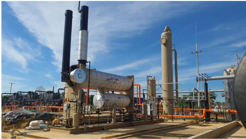
Ilustración 16. Unidad deshidratadora Fuente: Autor con datos asociados de la investigación
