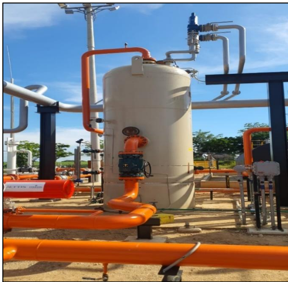
Ilustración 15. Separador Bifásico Fuente: Autor con datos asociados de la investigación
