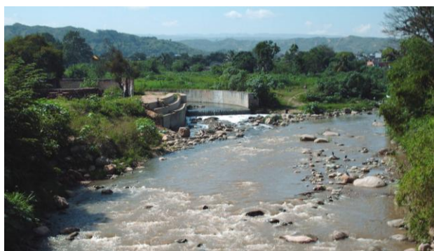
Foto 7. Desembocadura de la Quebrada La Iglesia al Río de Oro.
