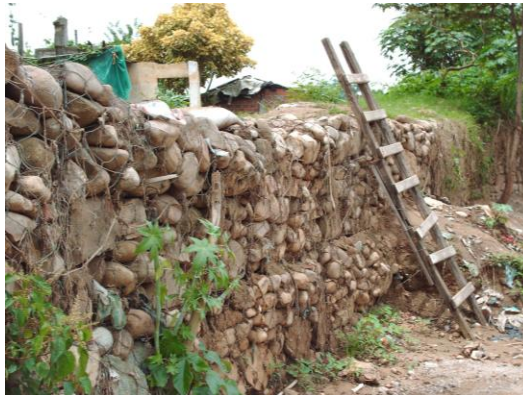
Foto 27. Sistema de gaviones que resistió a la avalancha de febrero de 2005. Asentamiento Arenales.
