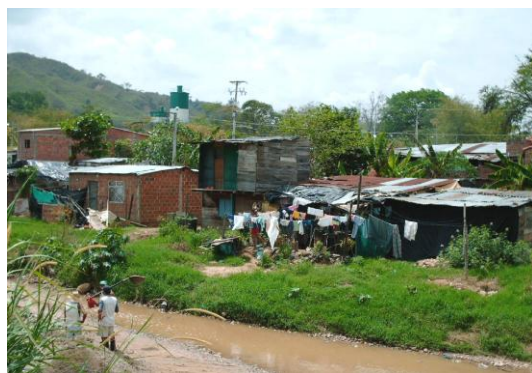
Foto 47. Parte posterior de unas viviendas del asentamiento Convivir, bordeando la quebrada Chimitá.
