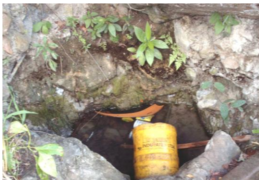
Foto 22. Pozo de agua subterránea a orillas de la vía férrea en el asentamiento Bocas del Túnel. Fuente: El autor.
