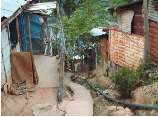
Foto 25. Tubería plástica de aguas servidas en el asentamiento Pablón Villa Lina. Fuente: El autor.
