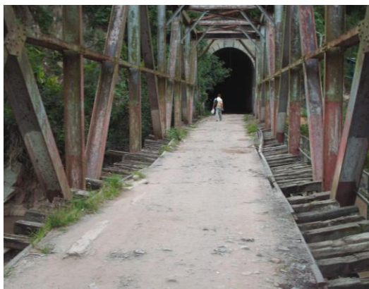
Foto 39. Túnel y puente que daban paso al tren procedente del Magdalena Medio Santandereano.
