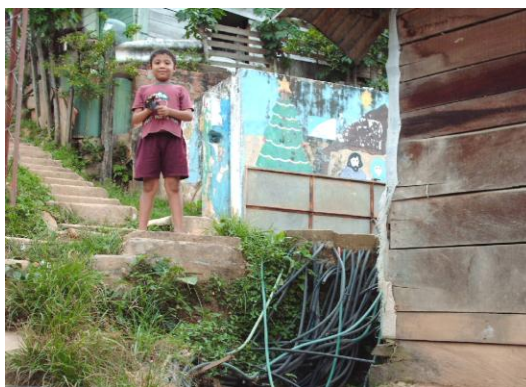
Foto 24. Red de mangueras conectadas a la pila comunitaria. Asentamiento Pablón Villa Lina. Fuente: El autor.
