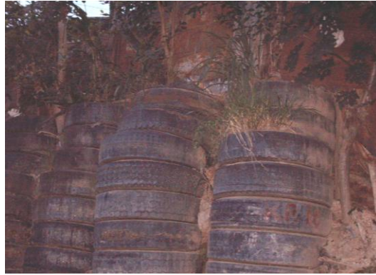
Foto 21. Vivienda sostenida con llantas. Asentamiento Pablón Villa Lina.
