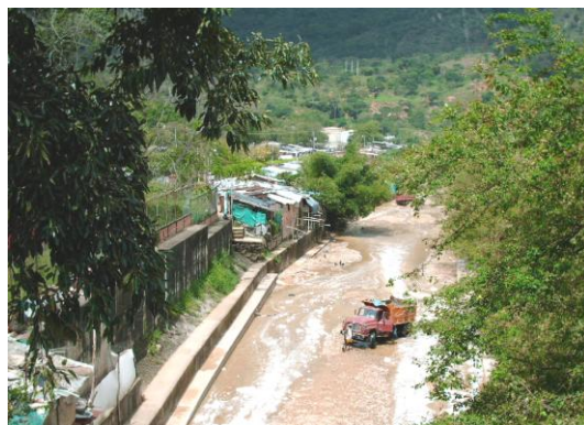
Foto 51. Primeras viviendas del asentamiento Altos de Andinas que van siguiendo el curso de la quebrada Chimitá.
