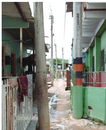
Foto 28. Aspecto de un vía peatonal pavimentada con materiales y mano de obra comunitarios. Asentamiento José Antonio Galán.
