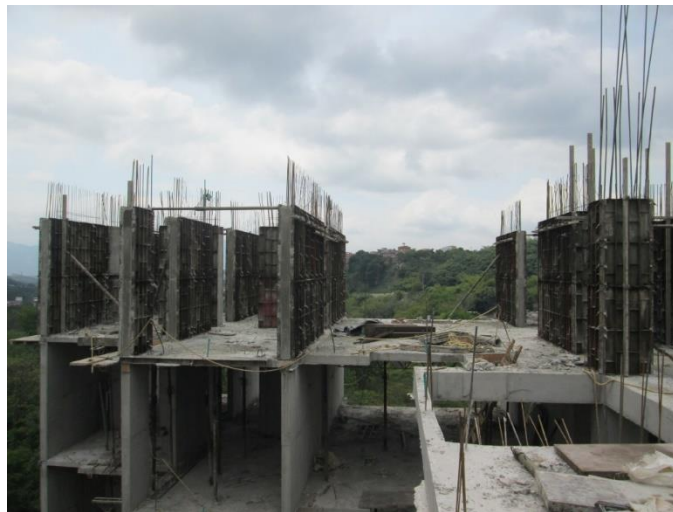
Figura 5. Formaletas armadas y fundidas
