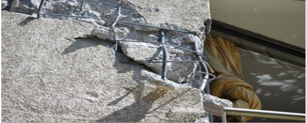
Figura 39. Edificio Central Park, malla de armadura en 90°
