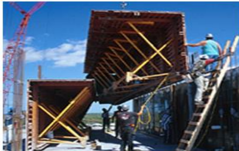
Figura 6. Armado de túnel en obra
