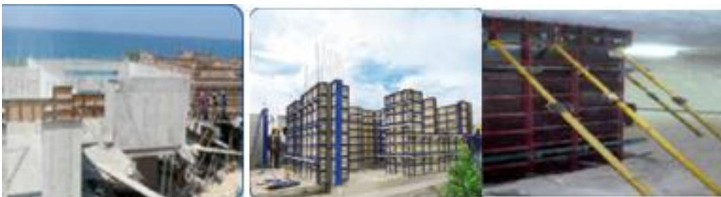
Figura 3. Formaleta para sistema manoportable [FORSA, 2013]
