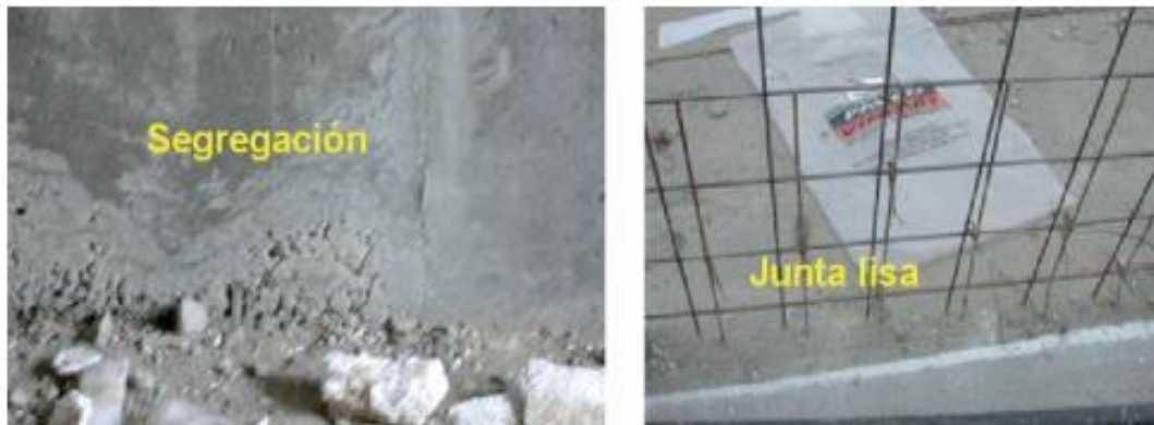
Figura 18. Algunas de las causas de la falla por deslizamiento
