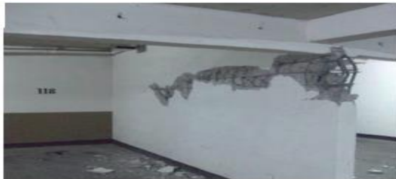
Figura 13. La falla se concentra principalmente en el borde libre
