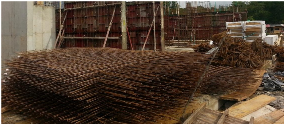
Figura 8. Mallas de refuerzo para muros
