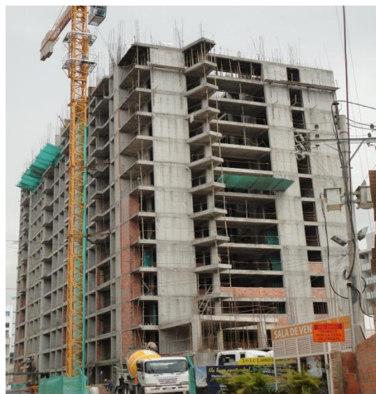
Figura 1. Edificio con sistema tipo túnel
