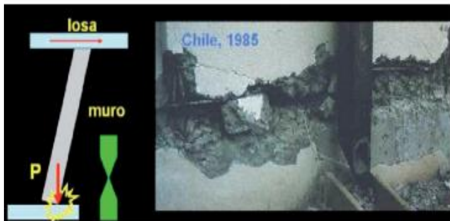
Figura 19. Consecuencias de la falla por deslizamiento
