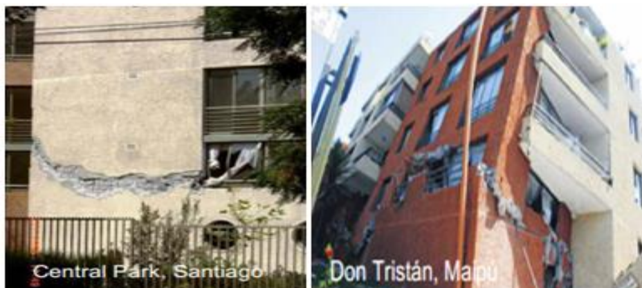
Figura 14. Efecto de cambio de longitud en los muros
