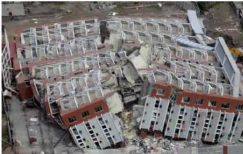
Figura 38. Colapso del edificio Alto Río
