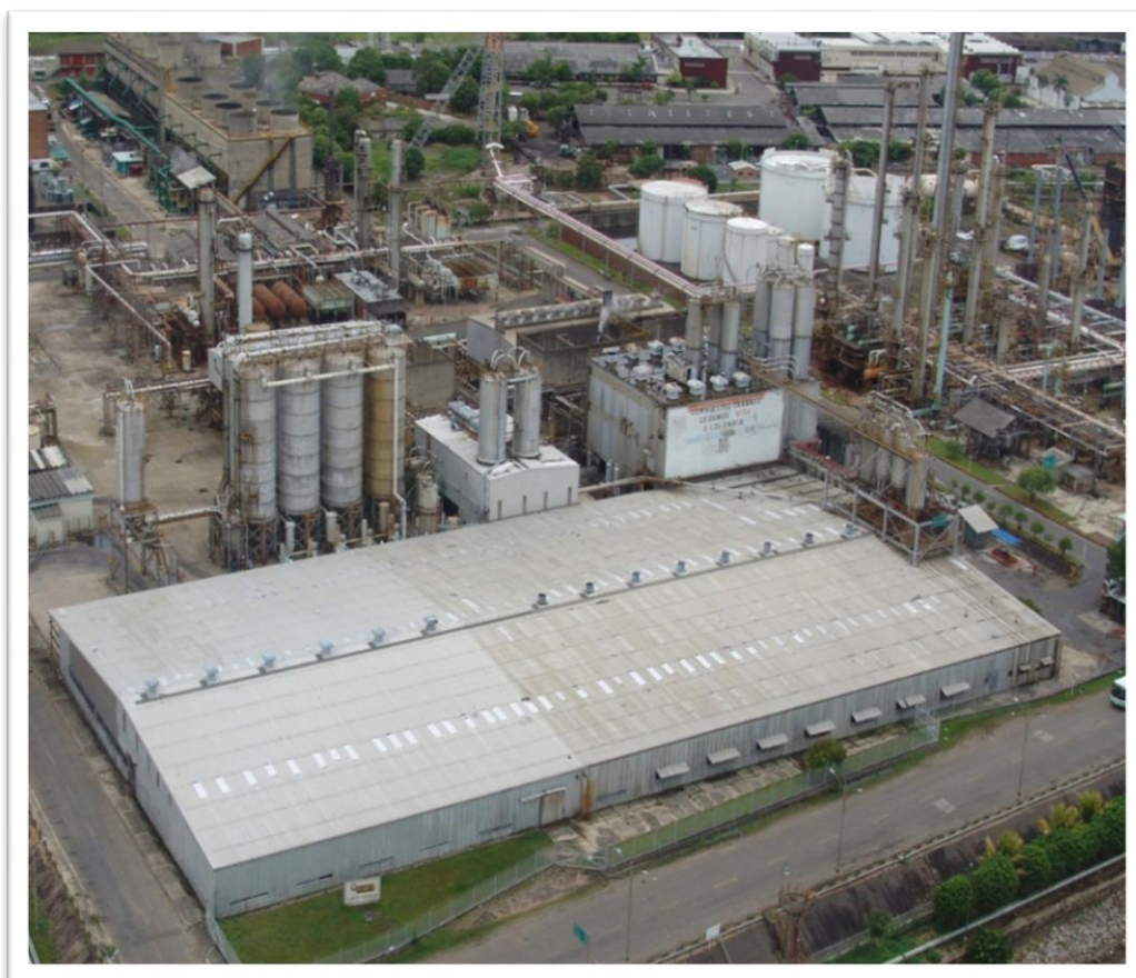
Figura 5. Departamento de petroquímica
