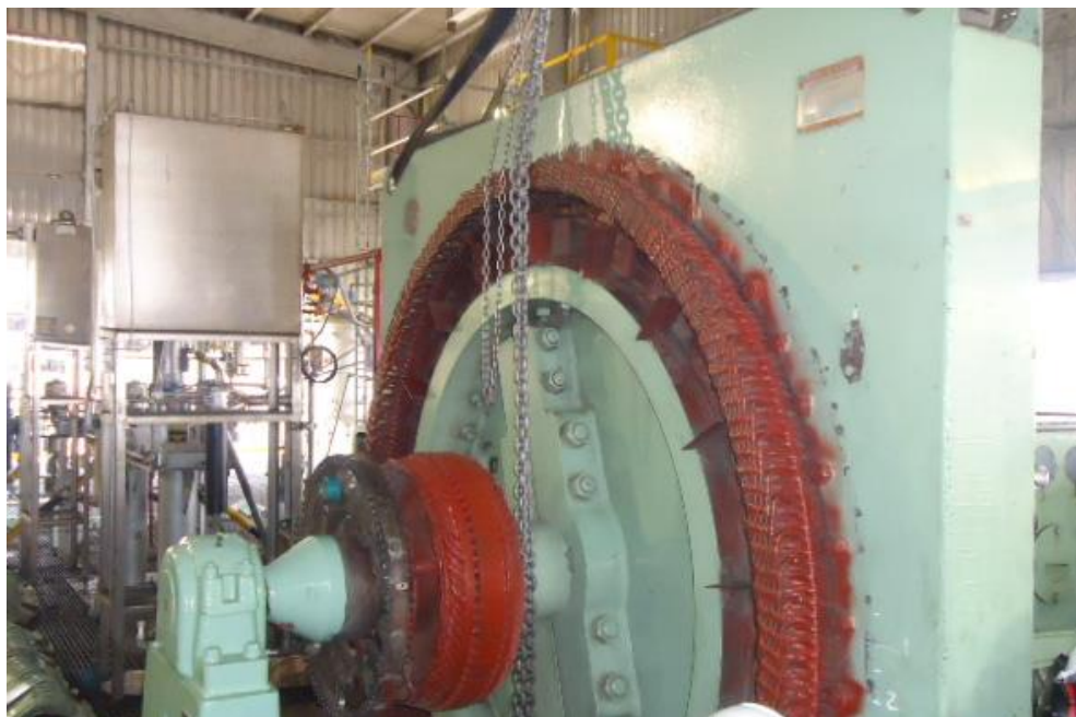
Figura 83. Montaje del estator
