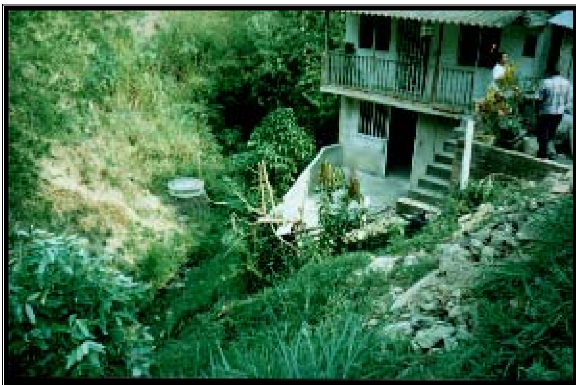
FIGURA 24: Fotografía de asentamientos en zona de riesgo Barrio Los Robles.
