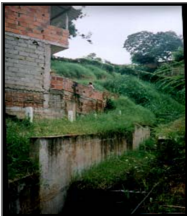
FIGURA 28: Fotografía de muro de contención construido como obra de mitigación.
