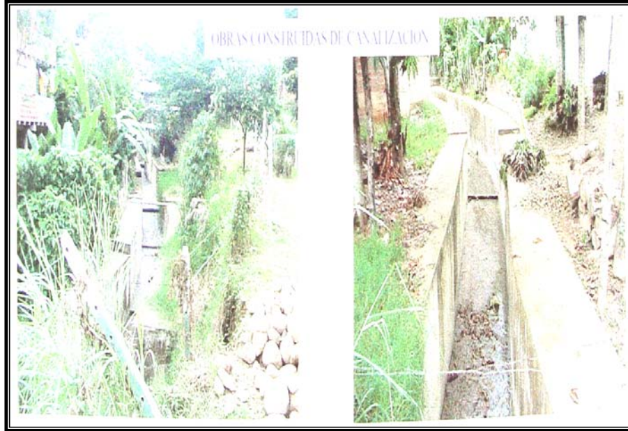
FIGURA 31: Fotografía de obras de mitigación para asentamientos de alto riesgo.
