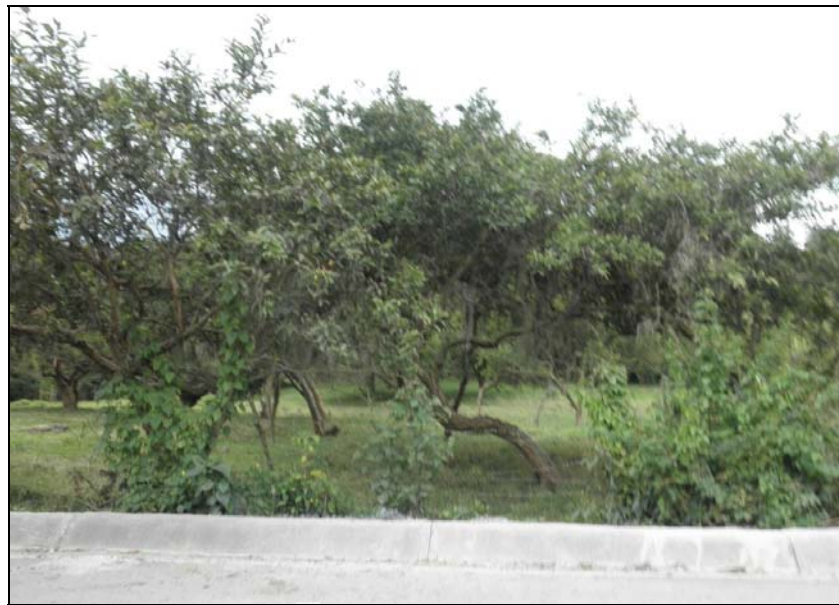
Figura 13. Fenómeno de Reptación en la vía.
