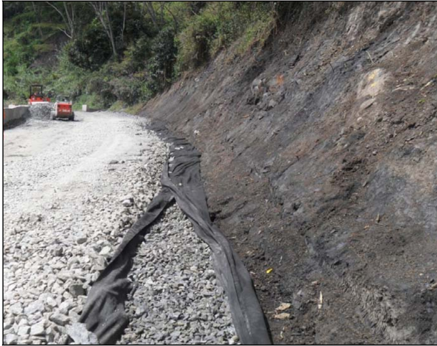
Colocación de filtro para control de aguas sub-superficiales en K3+130
