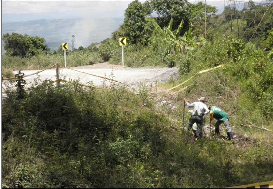
Excavación para toma de muestra en K3+100
