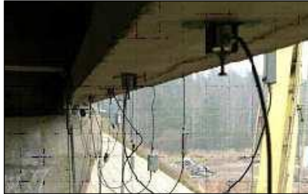
Figura 173. Inspección de puentes
