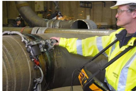
Figura 170. Inspección de soldadura en tubería
