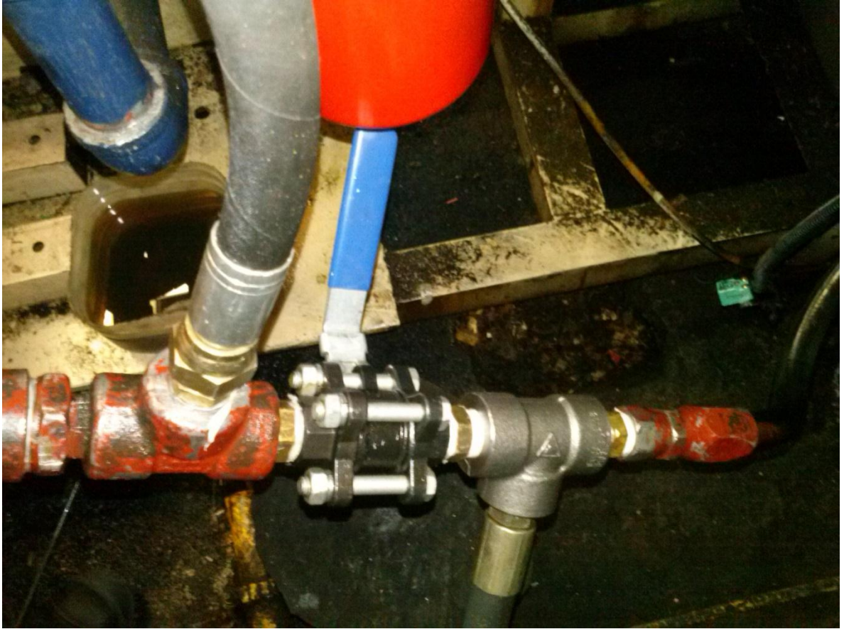
Figura 70: Válvula de bola.
