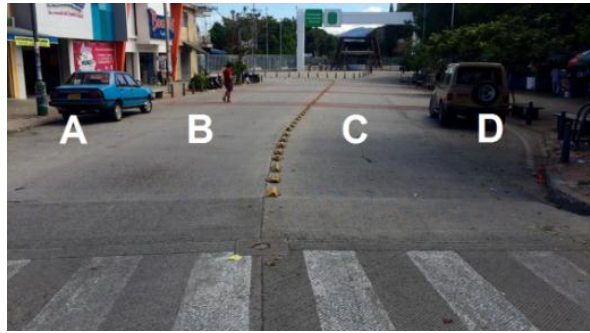
Figura 18. Expansión calzada Tramo 3 Fuente. Creación propia
