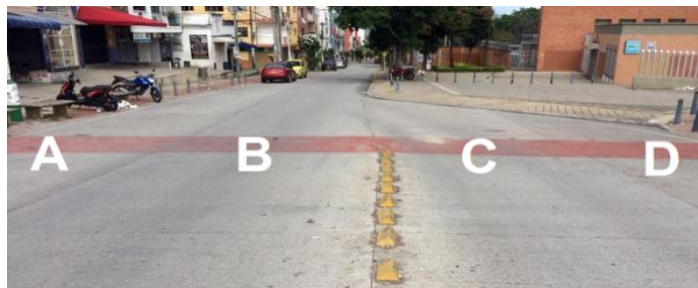
Figura 23. Reducción calzada Tramo 2.
