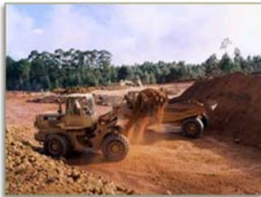
Figura 27. Extracción y almacenamiento de arcillas
