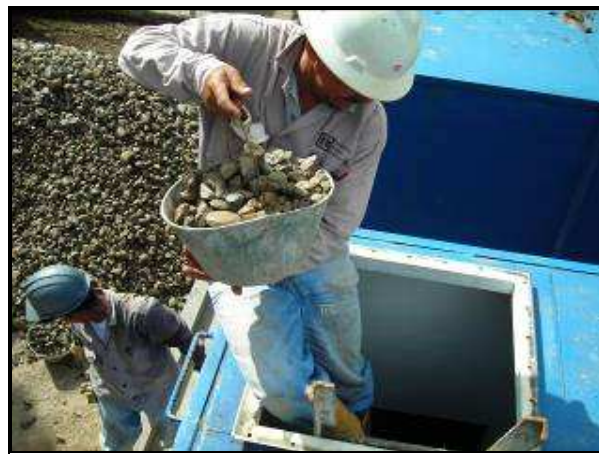
Figura 6. Suministro del medio filtrante de los filtros anaerobios
