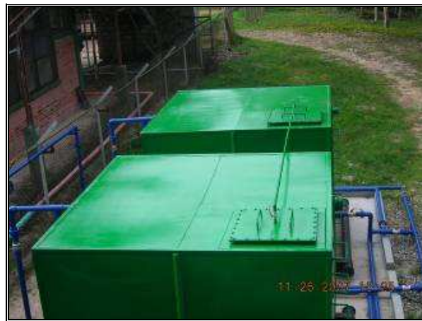
Figura 10. Sistema para evacuación de biogas
