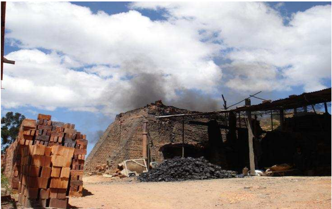
Fotografía 9. Horno Loco Ladrillera El Progreso
