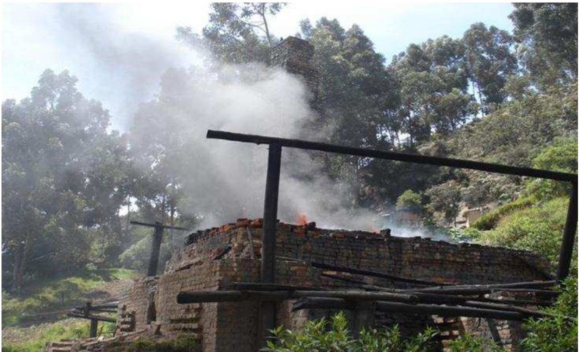
Fotografía 5. Emisión de material particulado Ladrillera Monasterio
