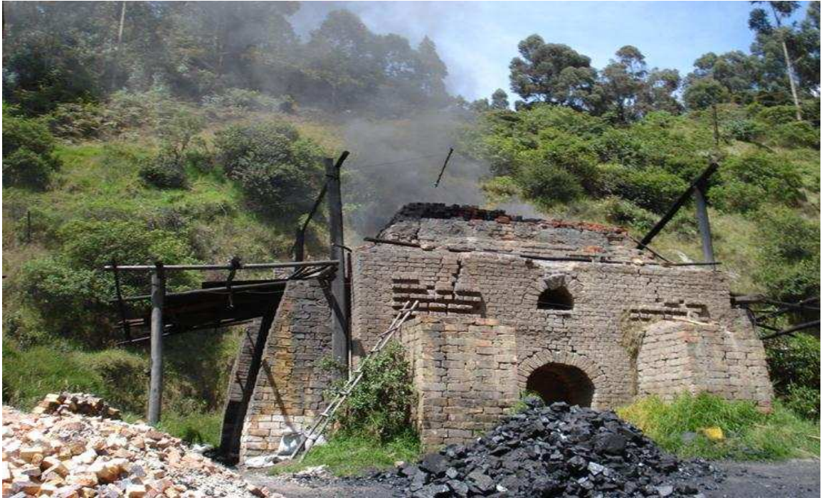
Fotografía 4. Horno Loco Ladrillera Monasterio
