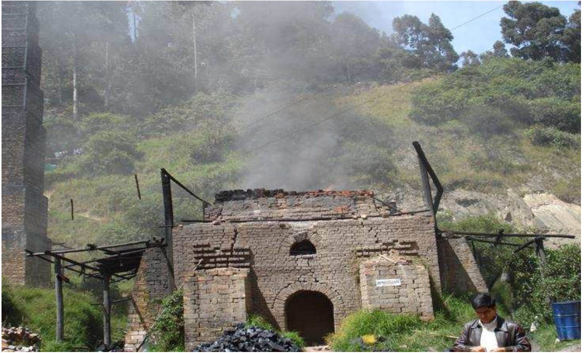
Fotografía 6. |Horno Loco Ladrillera Monasterio
