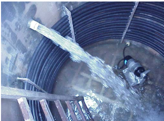
Foto No. 19 Biodigestor en funcionamiento
