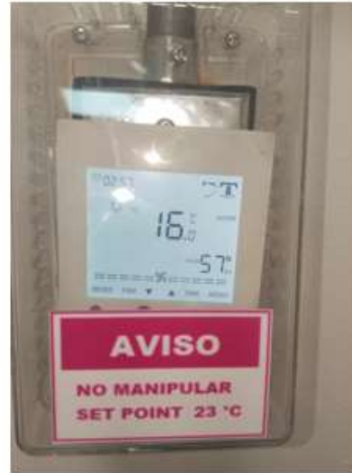
Termostato programable implementado
