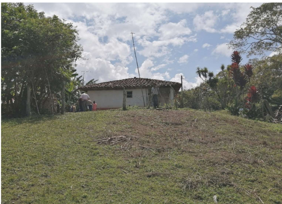
Figura. 103. Fotografía de vivienda rural en vereda San Jacinto y Chapa – Fachada lateral. Boyacá, noviembre 2021.
