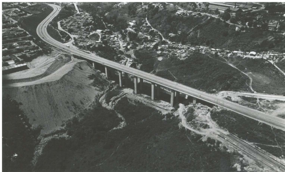
Figura. 165. Fotografía Viaducto Benjamín García Cadena. 1970.
