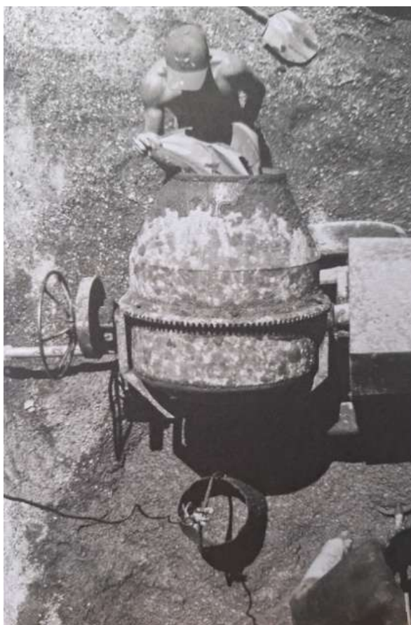
Figura. 79. Fotografía de hombre preparando concreto en una mezcladora manual
