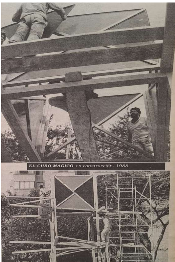
Figura. 191. Fotografía de “El Cubo Mágico” en construcción, 1988.
