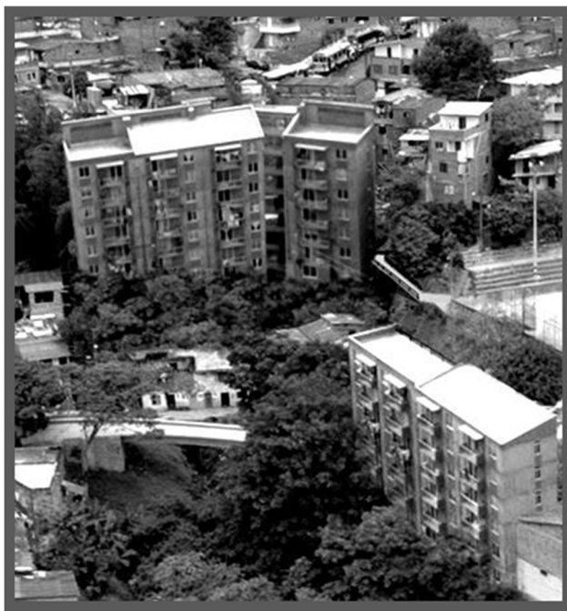
Figura. 97. Fotografía de torres de vivienda multifamiliar construidas dentro del proyecto de Consolidación Habitacional en el sector de la quebrada Juan Bobo en la ciudad de Medellín.
