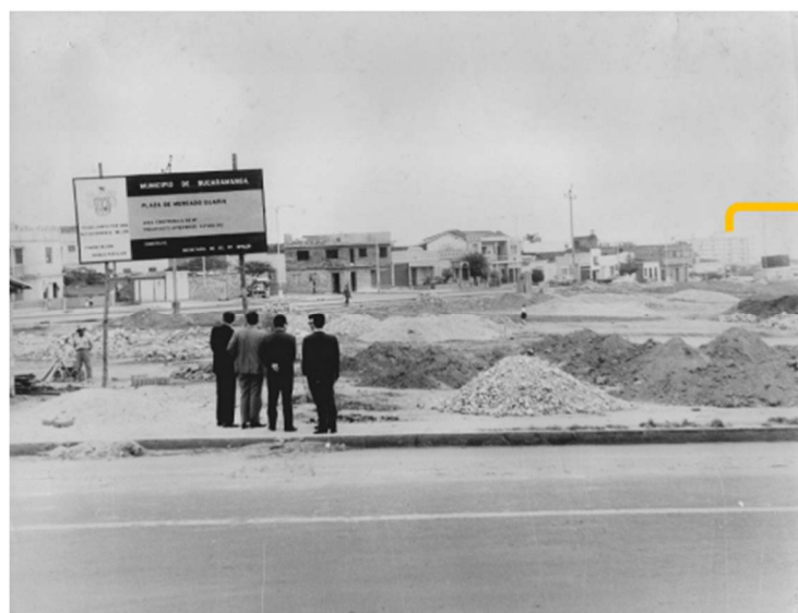
Figura. 232. Fotografía Archivo personal Roberto Diego Serpa Isaza - Plaza Guarín en construcción. Bucaramanga, 1968.
