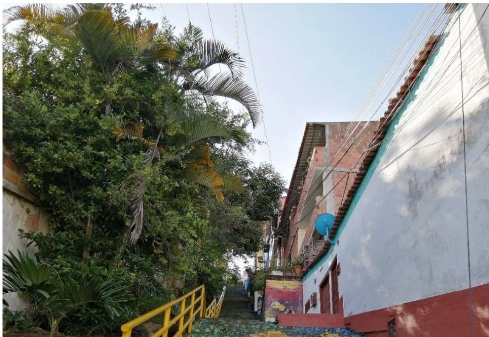
Figura. 63. Fotografía barrio Los Sauces (costado norte del barrio). Bucaramanga, junio 2021.
