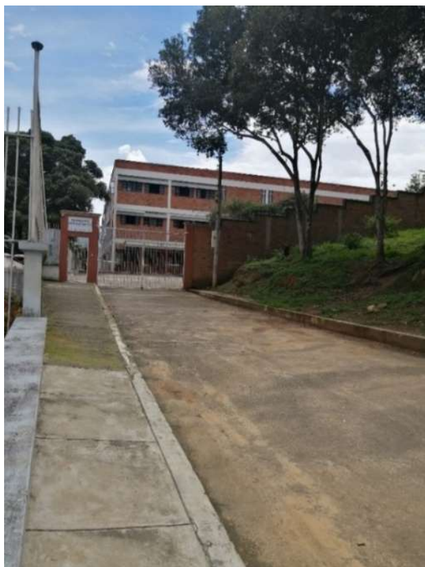
Figura. 73. Fotografía vía de acceso predio Hermanas Bethlemitas. Julio 2022
