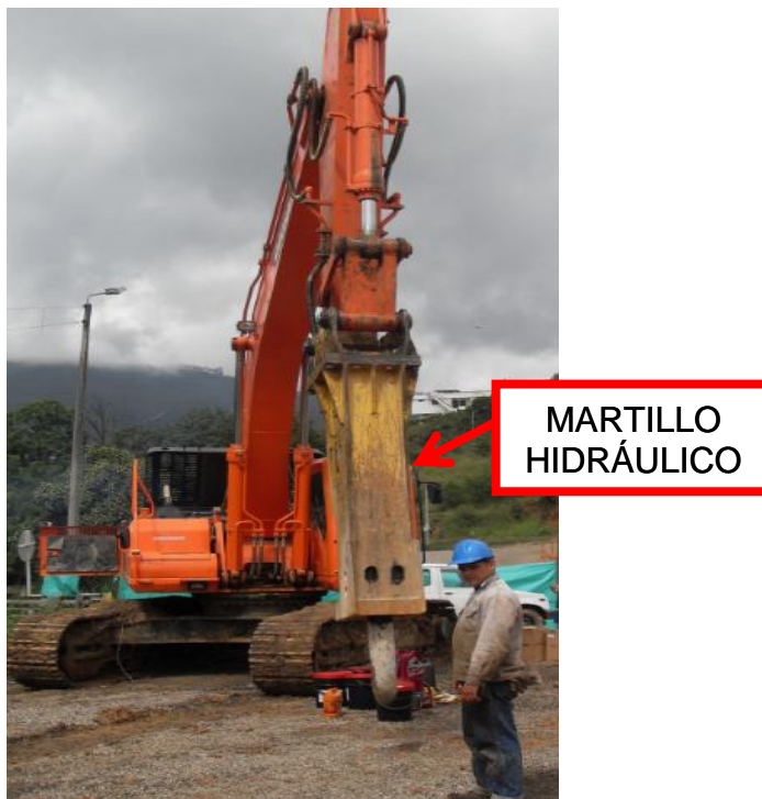
Figura 24. Excavadora con herramienta adicional (martillo hidráulico).
