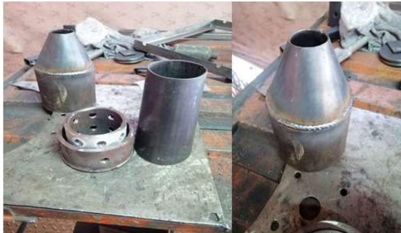
Figura 12. Construcción de las piezas del modelo funcional
