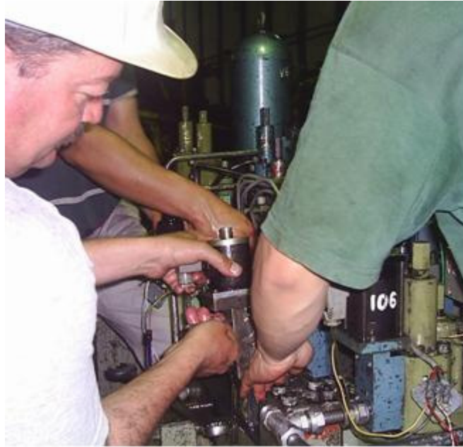
Figura 95. Desmontaje para Inspección de Válvulas en Manifold
