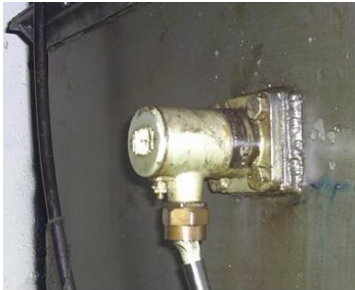
Figura 82. Interruptor de nivel
