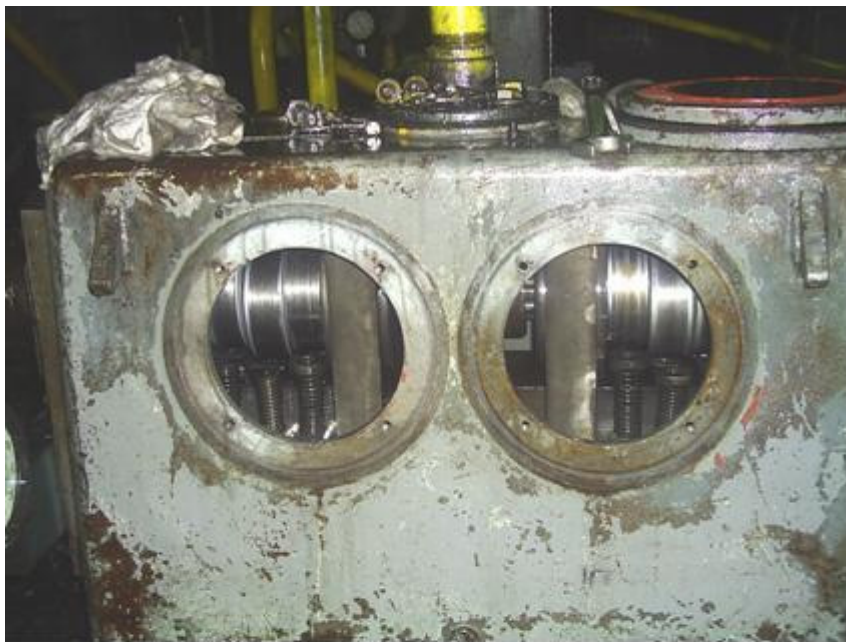
Figura 122. Montaje y Revisión de P5 y P6
