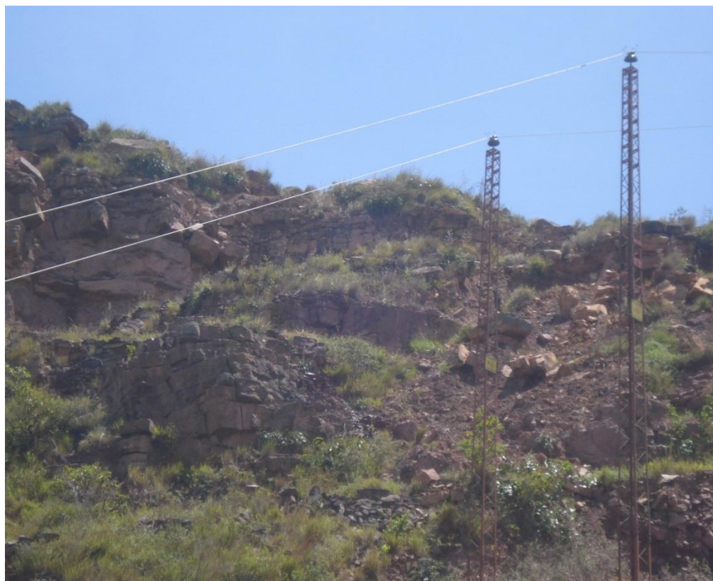
Fotografía 6. Torrecillas y red de media tensión existente.
