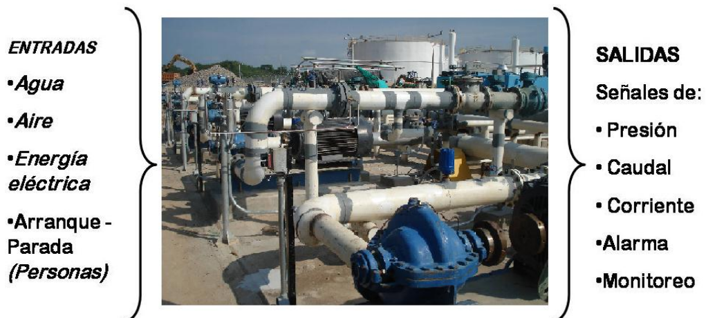
Figura 13. Límites de un Sistema de Bombeo
