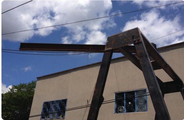
Figura 11. Instalación del mecanismo
