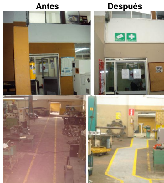
Imagen 11. Instalación señalización y mantenimiento demarcación (antes y después)
