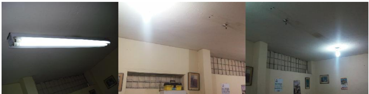
Imagen 17. Antes y después de luminarias en oficinas
