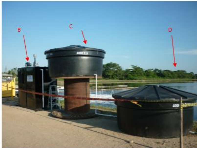
FIGURA 12 MONTAJE DE LA PRUEBA PILOTO EN CAMPO
