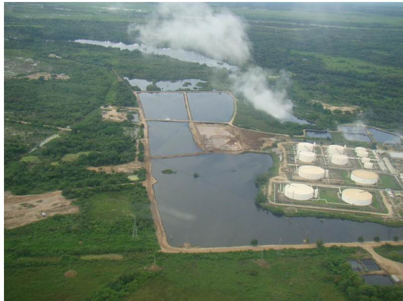
FIGURA 22 VISTA AÉREA DE LA FACILIDAD. SE OBSERVA EN EL MEDIO DE LA IMAGEN LA LAGUNA 4A SIN FLUJO DURANTE LA INTERVENCIÓN DE ADECUACIÓN DE TERRENO.
