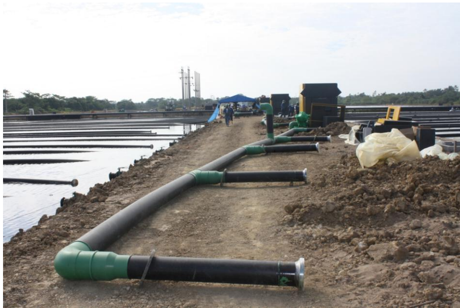
FIGURA 39 TENEDOR TERMINADO LISTO PARA SE POSICIONADO.
