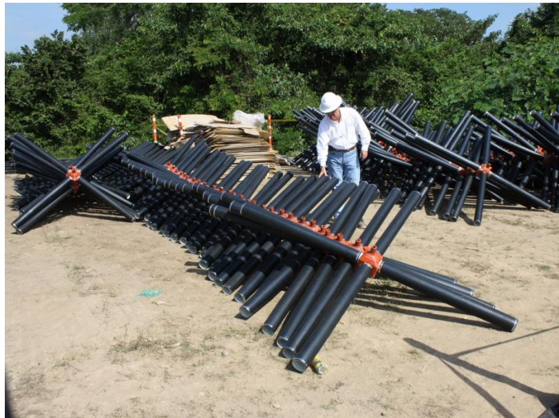
FIGURA 35 RACIMOS (CLUSTERS) ENSAMBLADOS PREVIA INSTALACIÓN.
