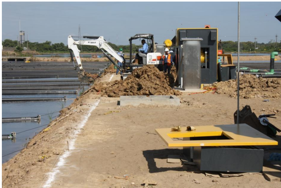
FIGURA 24 BERMAS EN PROCESO DE INSTALACIÓN DE TUBERÍAS.
