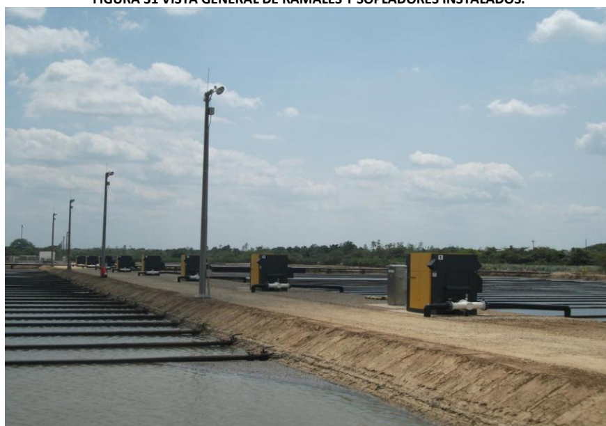
FIGURA 31 VISTA GENERAL DE RAMALES Y SOPLADORES INSTALADOS.
