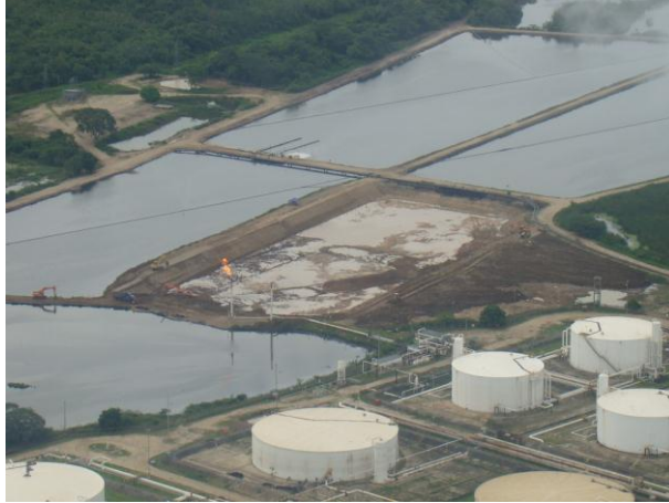
FIGURA 23 DETALLE DE LAGUNA 4A DURANTE ACTIVIDADES DE ADECUACIÓN DE TERRENO.
