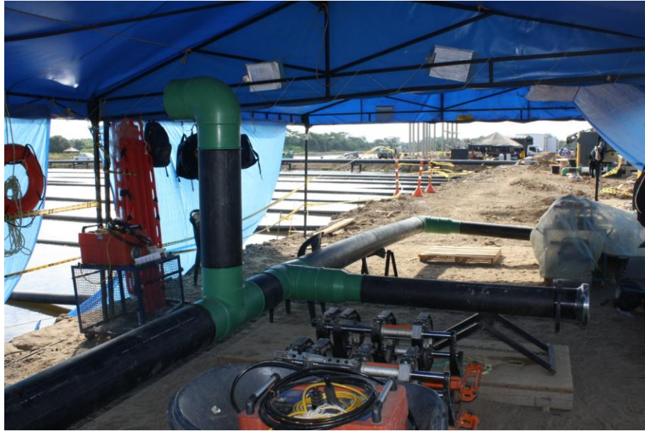
FIGURA 40 PROCESO DE ENSAMBLE DE LAS DOS MITADES DE UN TENEDOR.
