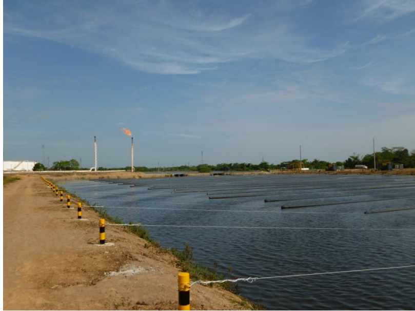
FIGURA 37 RAMALES EN POSICIÓN ANCLADOS CON CABLES DE ACERO.
