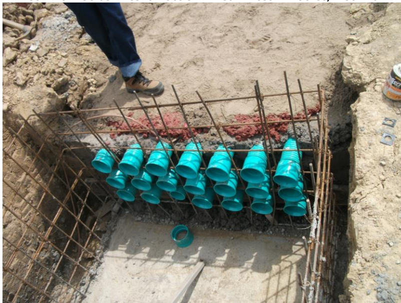
FIGURA 29 PROCESO DE CONSTRUCCIÓN DE LOS BANCOS DE DUCTOS, LAGUNA 5B.
