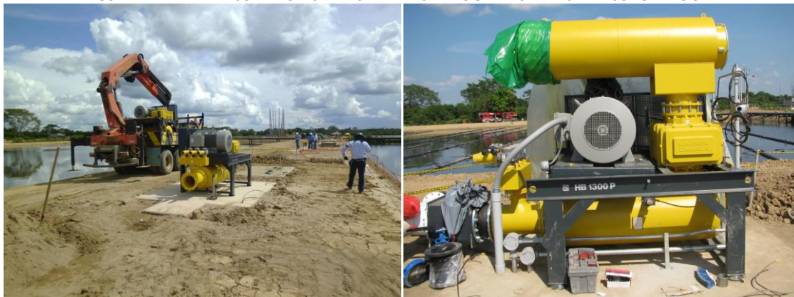
FIGURA 42 DETALLE DE SOPLADORES ANTES DE LA INSTALACIÓN DE CABINAS DE INSONORIZACIÓN.
