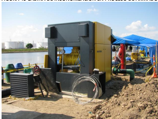
FIGURA 43 CABINA DE INSONORIZACIÓN EN PROCESO DE ARMADO.
