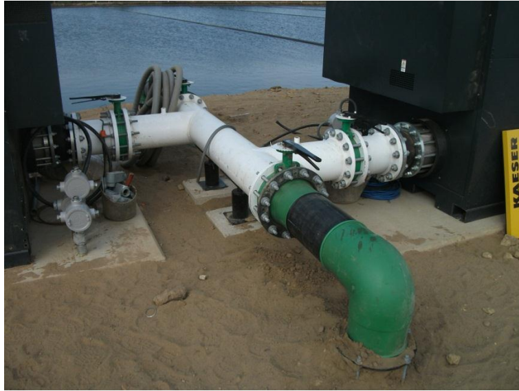
FIGURA 40 DETALLE DE ACOPLER PARA DISTRIBUCIÓN DE AIRE Y CAMBIO DE MATERIAL (DE ACERO A POLIPROPILENO).
