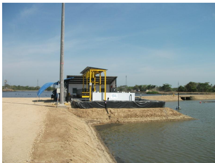
FIGURA 28 VISTA FINAL PLATAFORMA ADICIONAL PARA PATÍN DE NUTRIENTES (CHEMDOSE). LAGUNA 4B.
