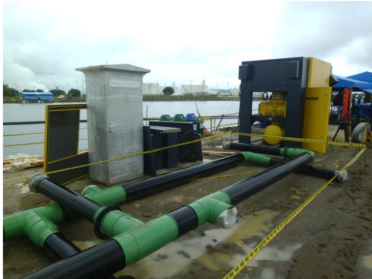
FIGURA 38 SE OBSERVAN LAS DOS MITADES DE UN TENEDOR LISTO PARA SER ENSAMBLADO.
