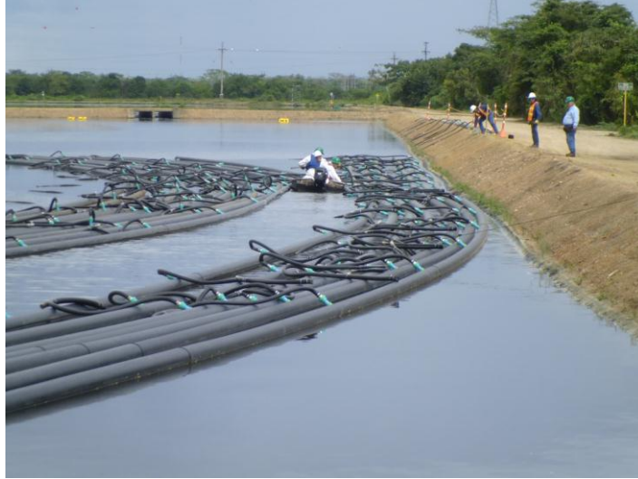
FIGURA 34 RAMALES EN EL AGUA LUEGO DE LA PRUEBA DE HERMETICIDAD LISTOS PARA SER REMOLCADOS.
