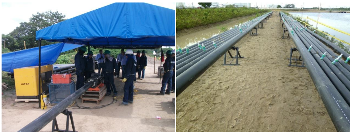
FIGURA 33 EQUIPO DE TERMOFUSIÓN EMPLEADO EN LA FABRICACIÓN DE RAMALES Y TENEDORES.
