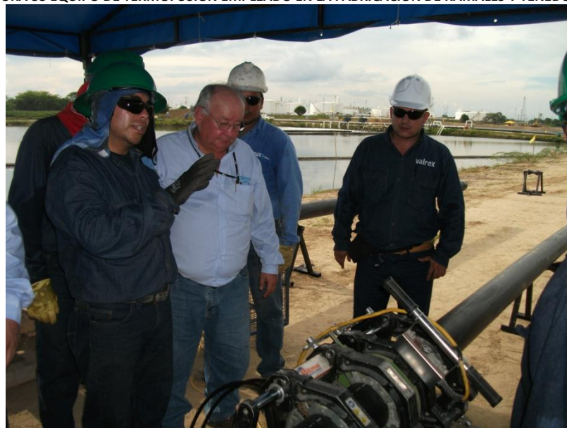
FIGURA 33 EQUIPO DE TERMOFUSIÓN EMPLEADO EN LA FABRICACIÓN DE RAMALES Y TENEDORES.
