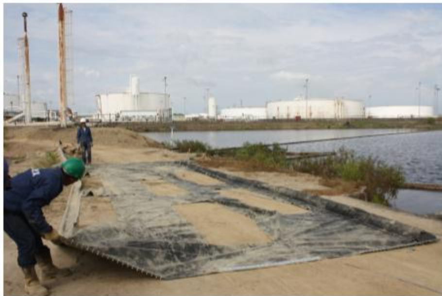
FIGURA 47 OPERARIO PREPARANDO UNO DE LOS BAFLES PARA SER DESPLEGADO EN LA LAGUNA.
