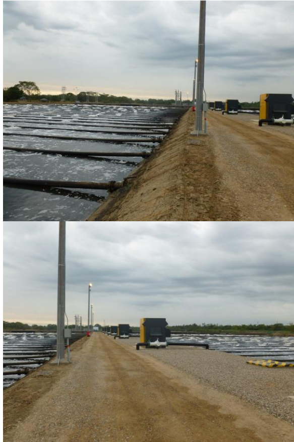
FIGURA 25 DETALLE DE TALUD PERFILADO CON RAMALES FLOTANTES SOBRE LA LAGUNA 4B.
