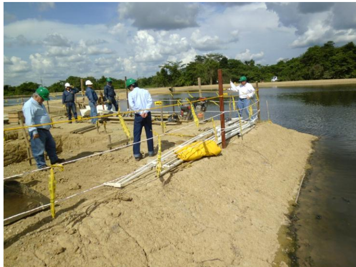
FIGURA 27 VISTA INICIAL PLATAFORMA ADICIONAL PARA PATÍN DE NUTRIENTES (CHEMDOSE). LAGUNA 4B.
