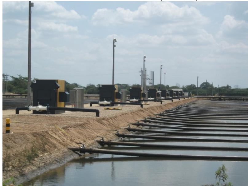
FIGURA 41 VISTA FINAL DEL CONJUNTO SOPLADOR-TENEDOR (ENTERRADO)-RAMALES FLOTANTES.
