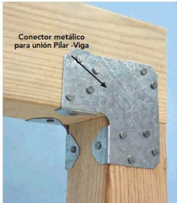
Figura 18. Detalle conexión vigueta con pilar.
