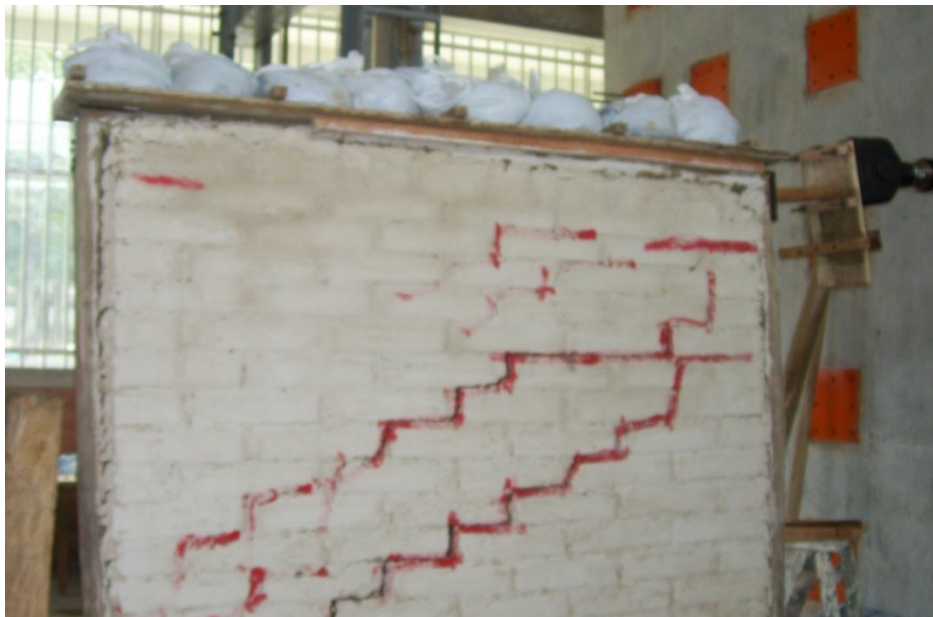
Figura 38. Falla agrietamiento muro con confinamiento
