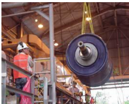
Figura 28. Proceso de remoción del barril en un compresor centrífugo
