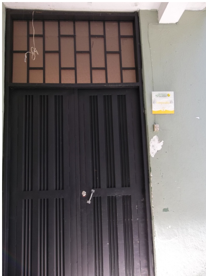
Foto 1. Entrada a la Unidad de Inimputables
