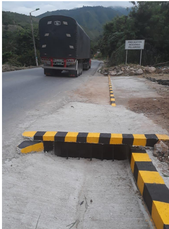
Figura 7. Cuneta reconstruida.
