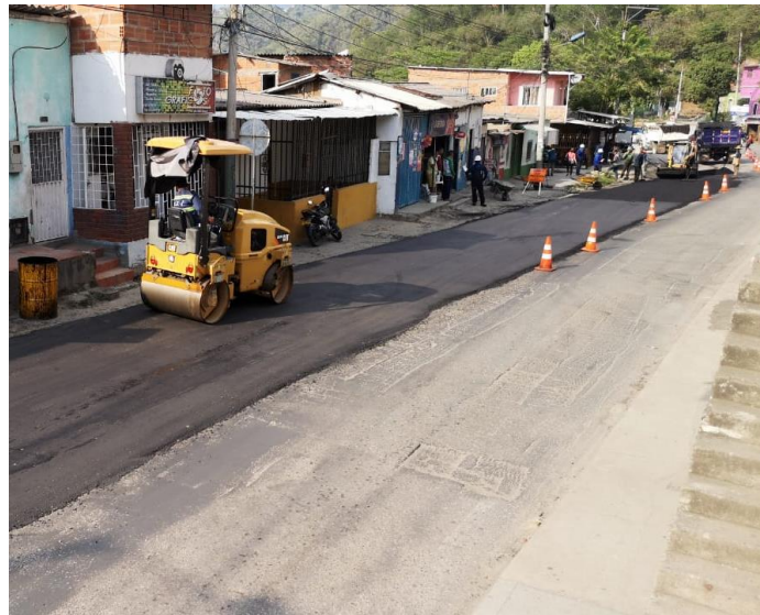
Figura 8. Mejoramiento de calzada, Café Madrid.
