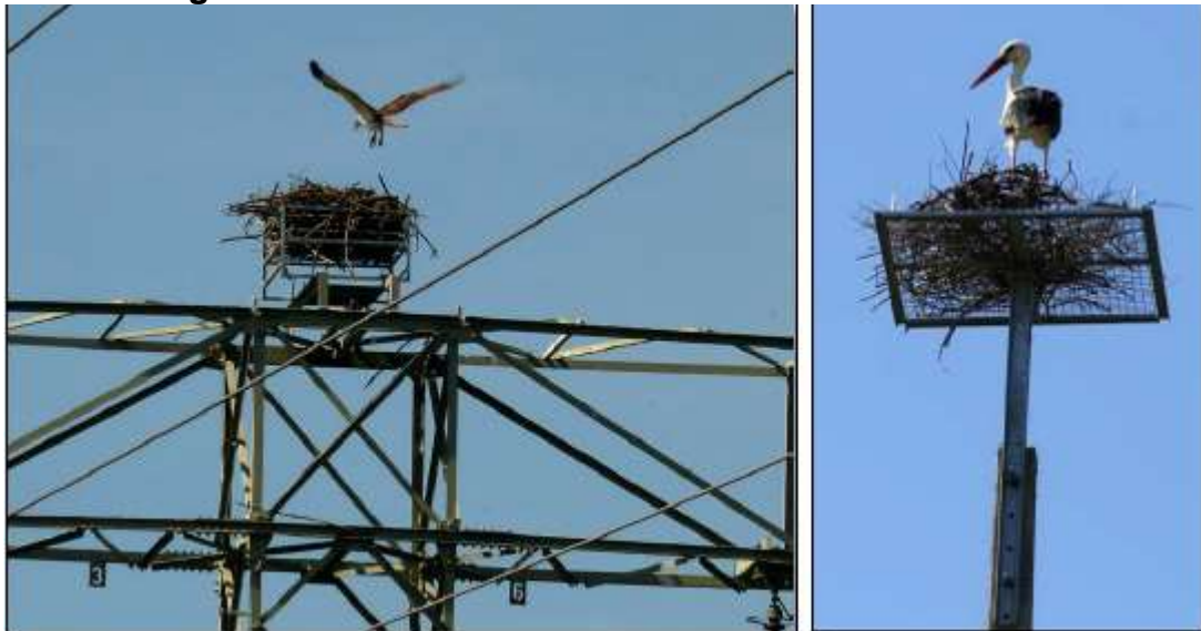
Figura 33: (a) águila pescadora anidando en plataforma de anidación artificial en línea de transmisión en Alemania; (b) cigüeña anidando en dispositivo artificial en Argelia
