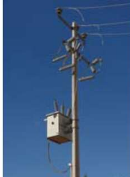
Figura 18: Apoyo de fin de línea con seccionador de corte al aire situado en el vástago.
