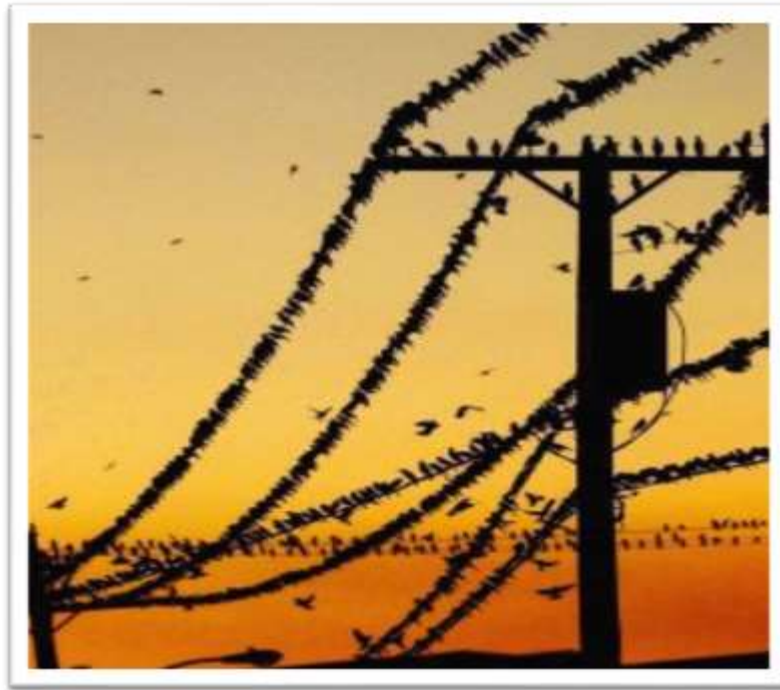
Figura 6. Centenar de aves posadas sobre el cableado eléctrico.
