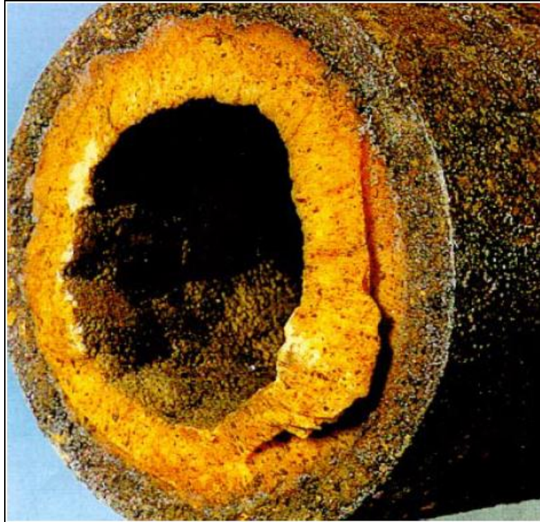
Figura 1. Reducción del flujo de hidrocarburos por la depositación de sólidos.
