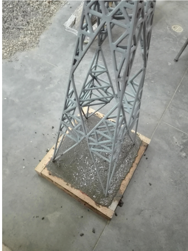
Figura 21. Fraguado loza de concreto estructural
