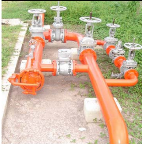
Figura 31. Sistema de Limpieza del Gasoducto
