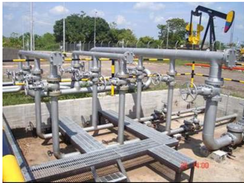
Figura 24. Múltiples de prueba y varios en la entrada a los separadores
