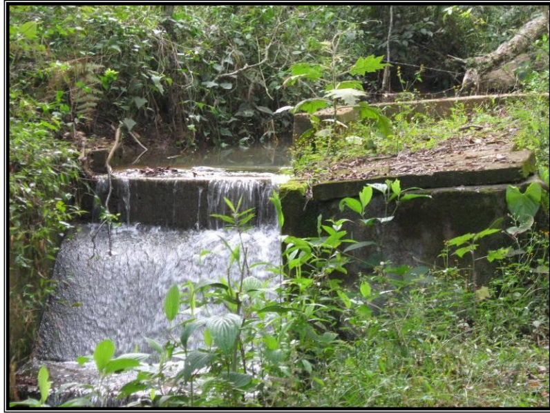
Figura 3. Bocatoma Quebrada La Sánchez
