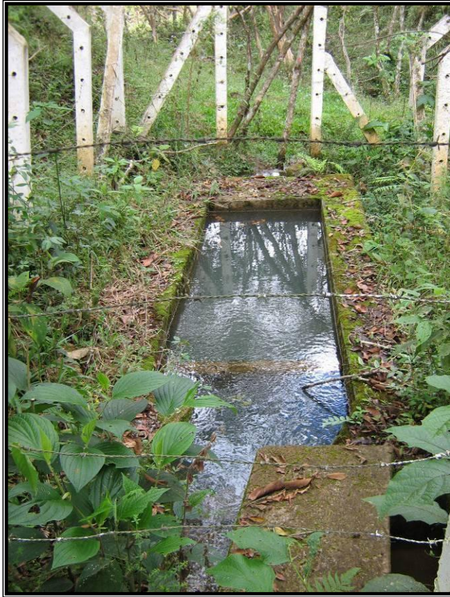
Figura 6. Detalle Desarenador – Quebrada la Sánchez
