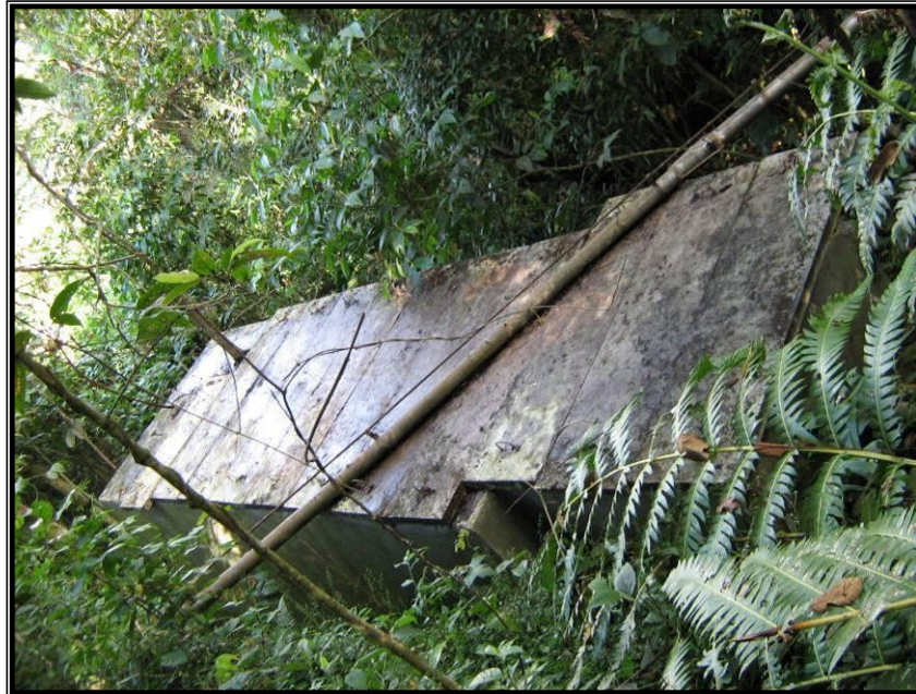
Figura 5. Detalle Desarenador Quebrada la Guaba
