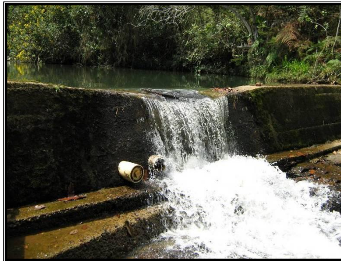
Figura 4. Bocatoma Quebrada la Chorrera.
