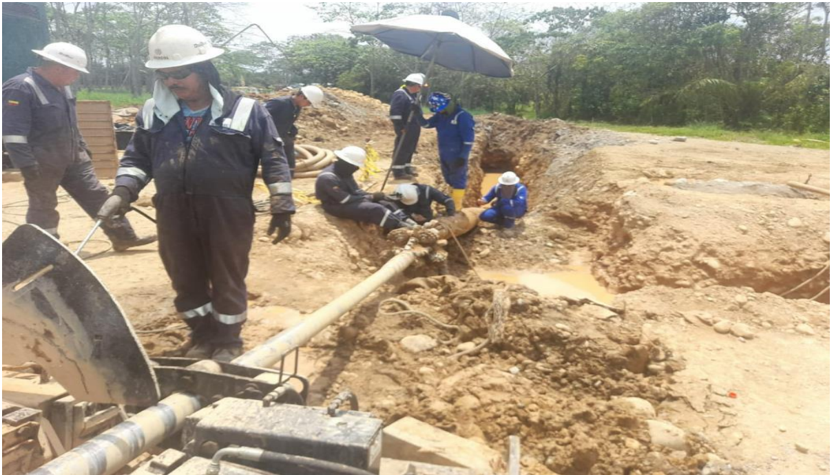
Figura 23. Perforación Horizontal Dirigida Halado de Tubería
