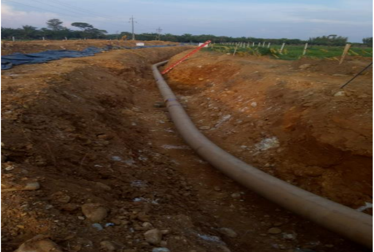
Figura 26. Técnica a Cielo Abierot - Zanja
