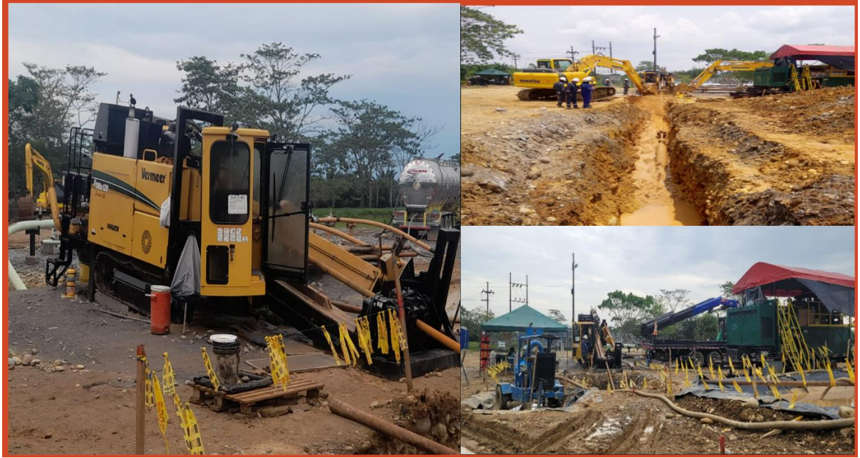
Figura 24. Fundamentales Perforación Horizontal Dirigida
