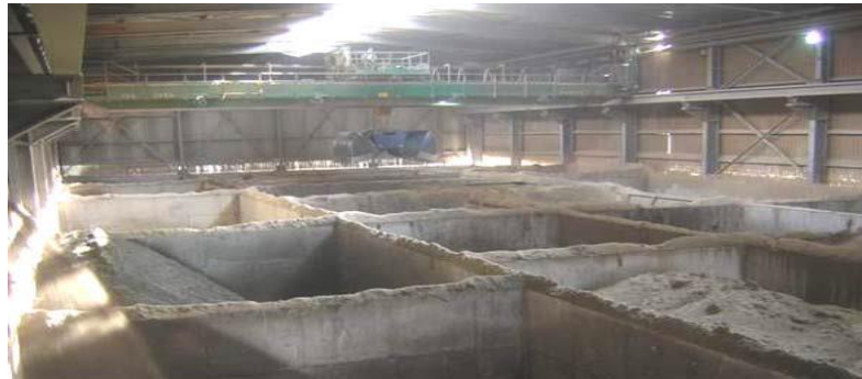
Figura 16. Puente grúa Brun
