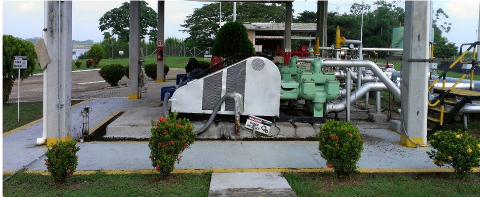
Figura 34. Bombas de despacho Estación Isla 4.
