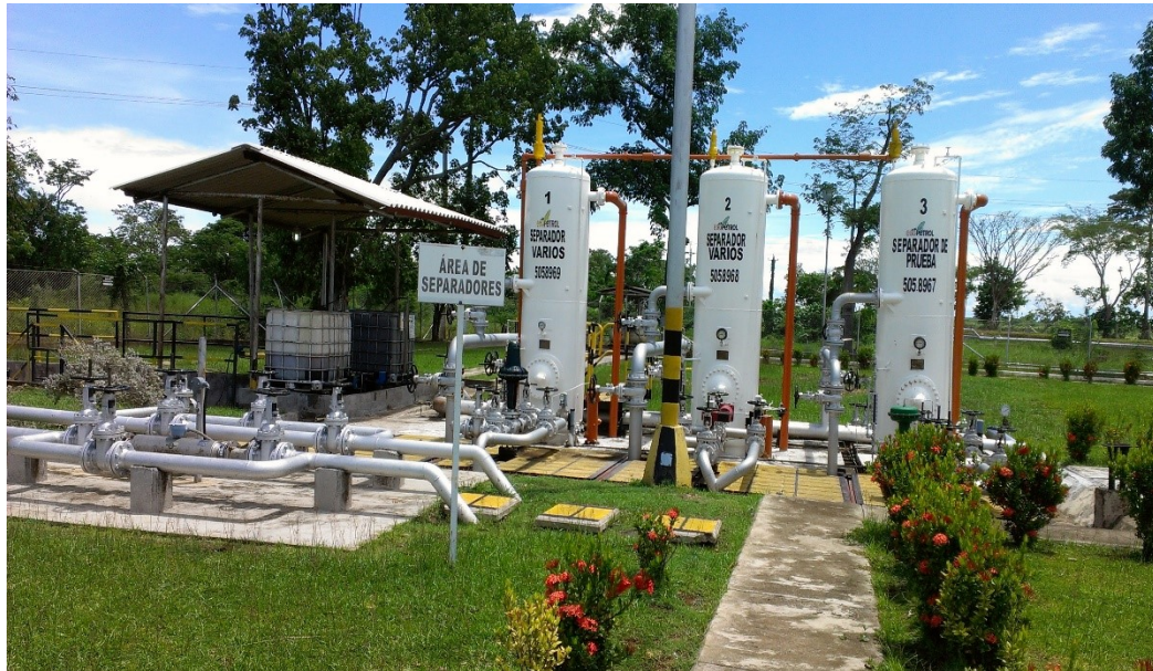
Figura 27. Zona de separadores Estación Auxiliar.
