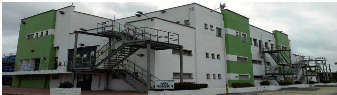
Figura 40. Planta de inyección de Agua (PIA)
