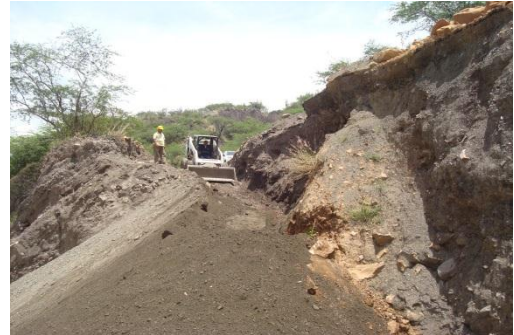
Fotografía 2 Excavación y acceso al muro de tierra armada
