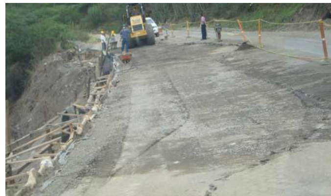
Fotografía 17 Terminación de capa 20
