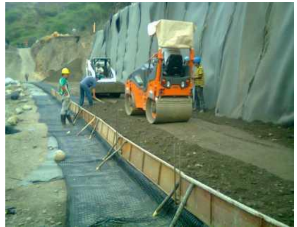
Fotografía 8 Compactación de material de relleno de muro de tierra armada
