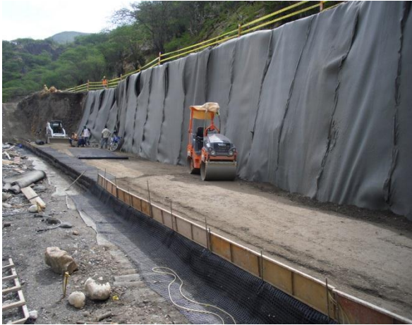
Fotografía 9 Proceso de capa 2 espesor 0.20 mts
