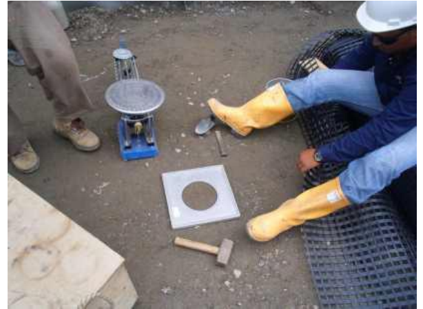
Fotografía 11 Toma de densidad con cono de arena para recibir capa 3 por parte de interventoría.
