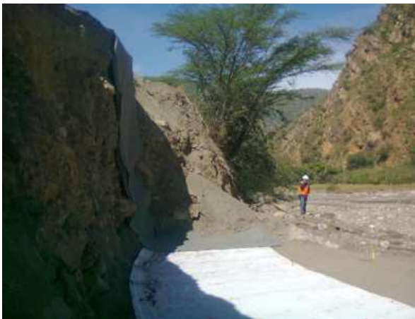
Fotografía 4 Instalación de Geotextil NT 4000.
