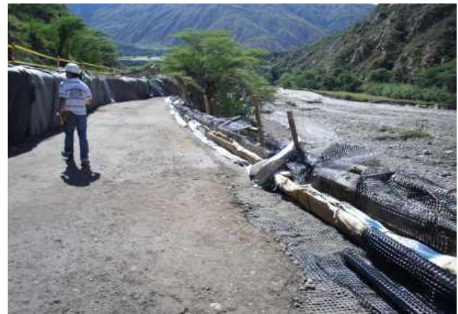
Fotografía 16 Terminación de muro tierra armada capa 19
