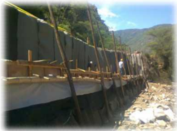
Fotografía 14 Recomendación de especialista, instalación de Geotextil NT 1600
