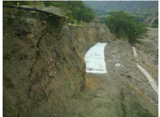
Fotografía 3 Nivelación y Replanteo del muro de tierra armada
