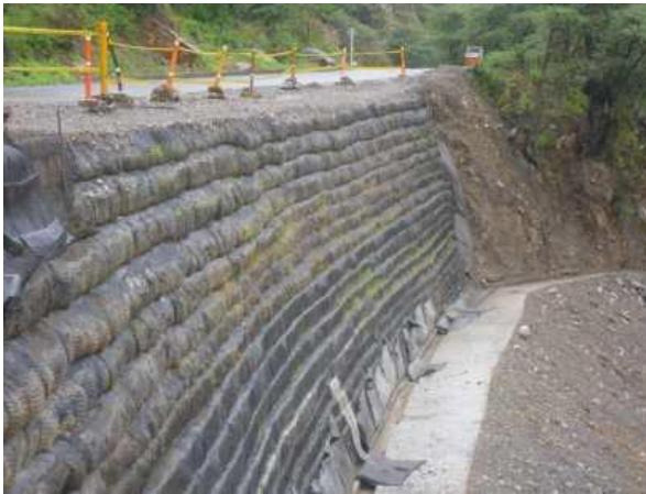
Fotografía 19 Construcción de Zanjas y losa en concreto en pata de muro de tierra armada
