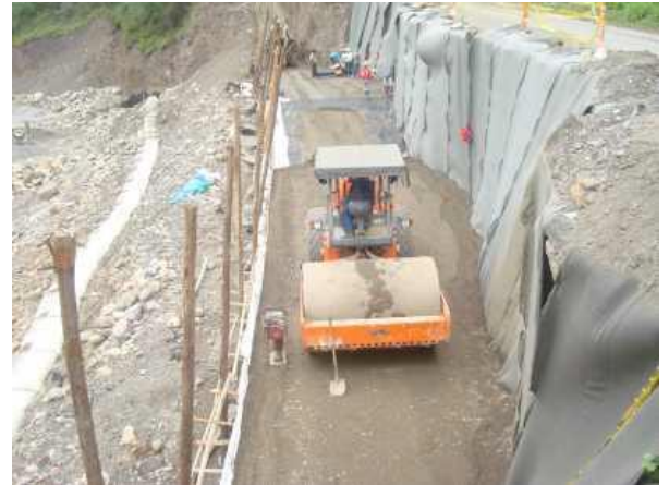
Fotografía 13 Compactación de material de relleno de capa 5
