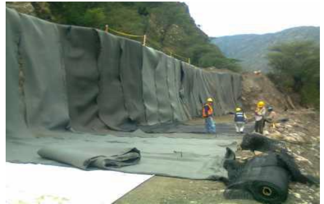
Fotografía 5 Instalación de Geodren planar.
