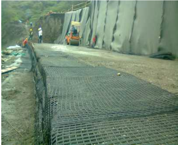
Fotografía 10 Acabado de capa 3 con geomalla uniaxial traslapa para capa 4
