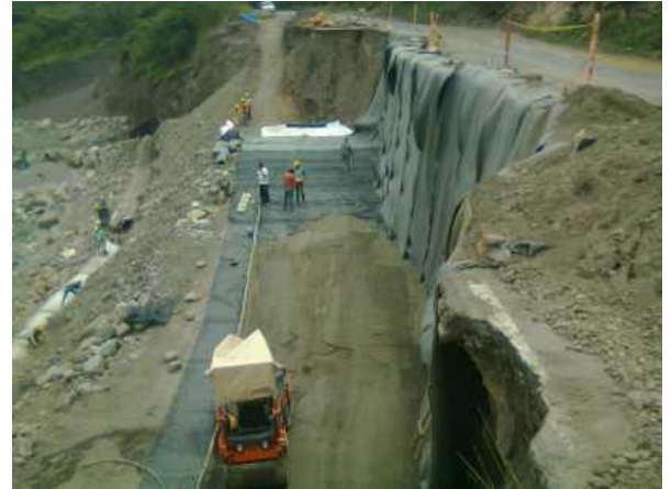
Fotografía 7 Colocación de formaleta y Extensión de material de relleno
