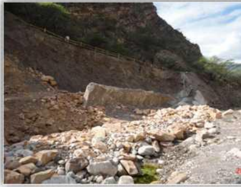
Fotografía 1 Localización Muro en tierra armada Km 11+070
